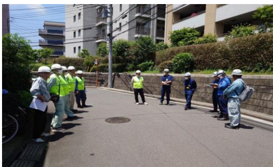
パトロール実施状況 下水道再整備
