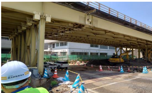
パトロール実施状況 陸橋補修・補強
